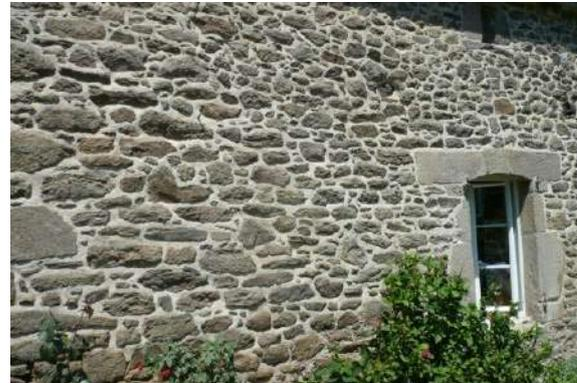
exemple de joints extérieurs chaux/sable
