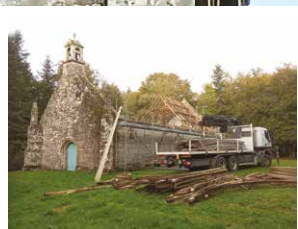
Chapelle du Cloître : démarrage des travaux
