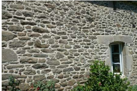
exemple de joints extérieurs chaux/sable
