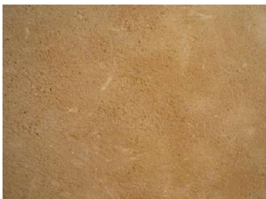
exemple d'enduit de finition à la chaux
